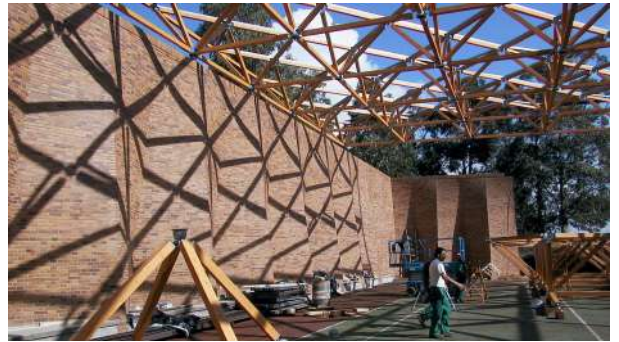
Mallas espaciais constituídas por barras ocas de madeira laminada
