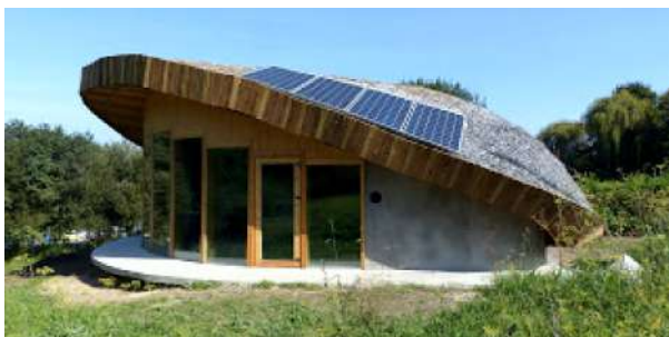
Módulo Biovalvo construído con cuncha de mexillón reciclada
