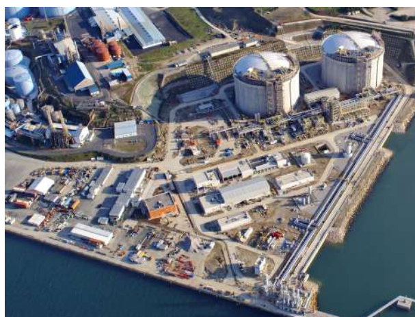
Planta de regasificación. Fase avanzada de obra (Lara 2007; Mugardos, Galicia)
