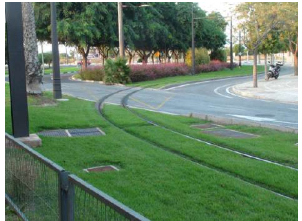
Vía de metro lixeiro en céspede en Alicante
