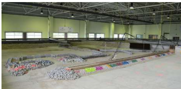
Dársena do Laboratorio de Portos e Costas do CITEEC. Superficie: 1000 m 2
