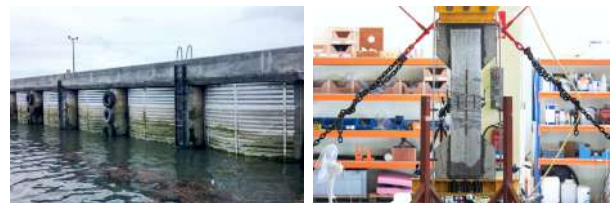
Peirao executado coa técnica pilote-lámina® e ensaio de reforzo a tracción con lámina de fibra de vidro
