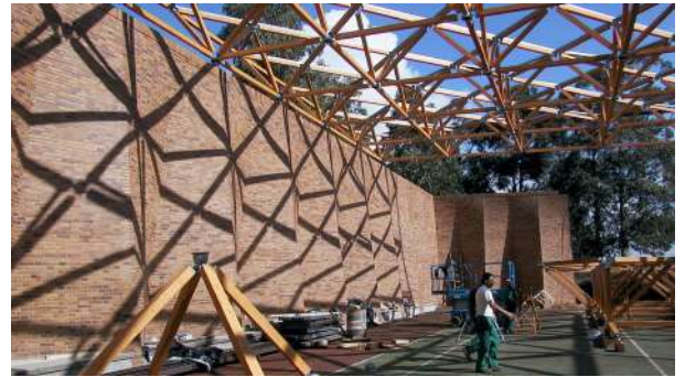
Mallas espaciales constituidas por barras huecas de madera laminada
