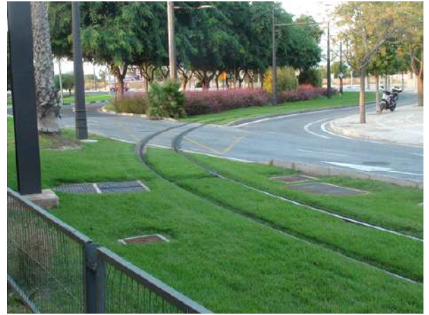
Vía de metro ligero en césped en Alicante
