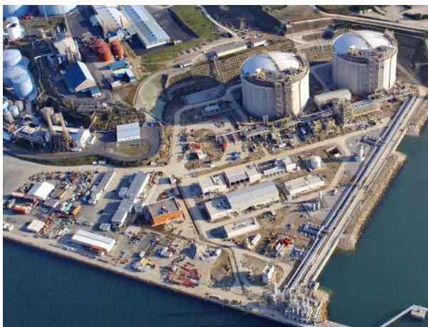
Planta de regasificación. Fase avanzada de obra (Lara 2007; Mugaridos, Galicia)
