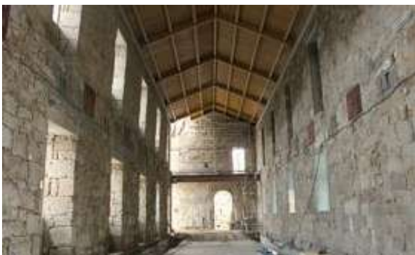
Rehabilitación de sistemas estructurales en edificios históricos
