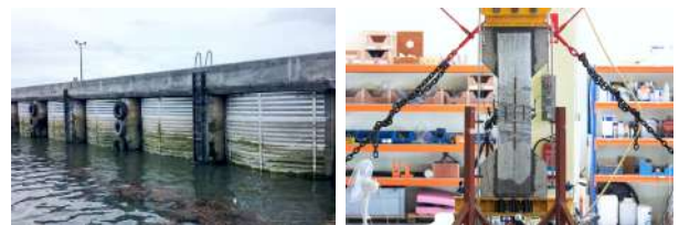
Muelle ejecutado con la técnica pilote-lámina® y ensayo de refuerzo a tracción con lámina de fibra de vidrio
