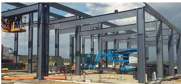
Módulo compacto de estructuras porticadas
